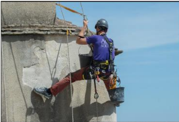
Jeu, au château de Montbéliard. Le crépi part en lambeaux sur les fortifications. Acro Solution effectue une reprise à la chaux. Photo ER/Christian LEMONTEY
