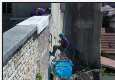
Versant rue de Belfort, les acrobates de la maçonnerie confortent les fortifications. Photo ER/Christian LEMONTEY
